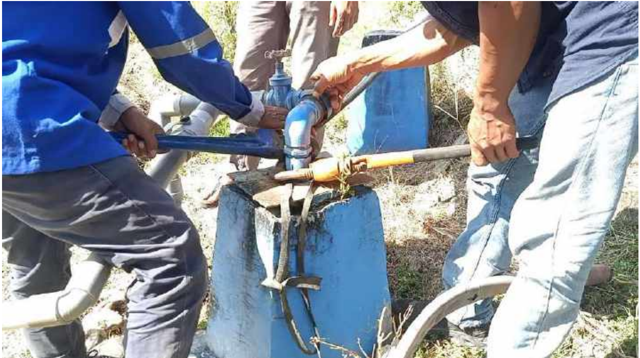
Gambar. Pembenahan pompa dan pergantian pipa
