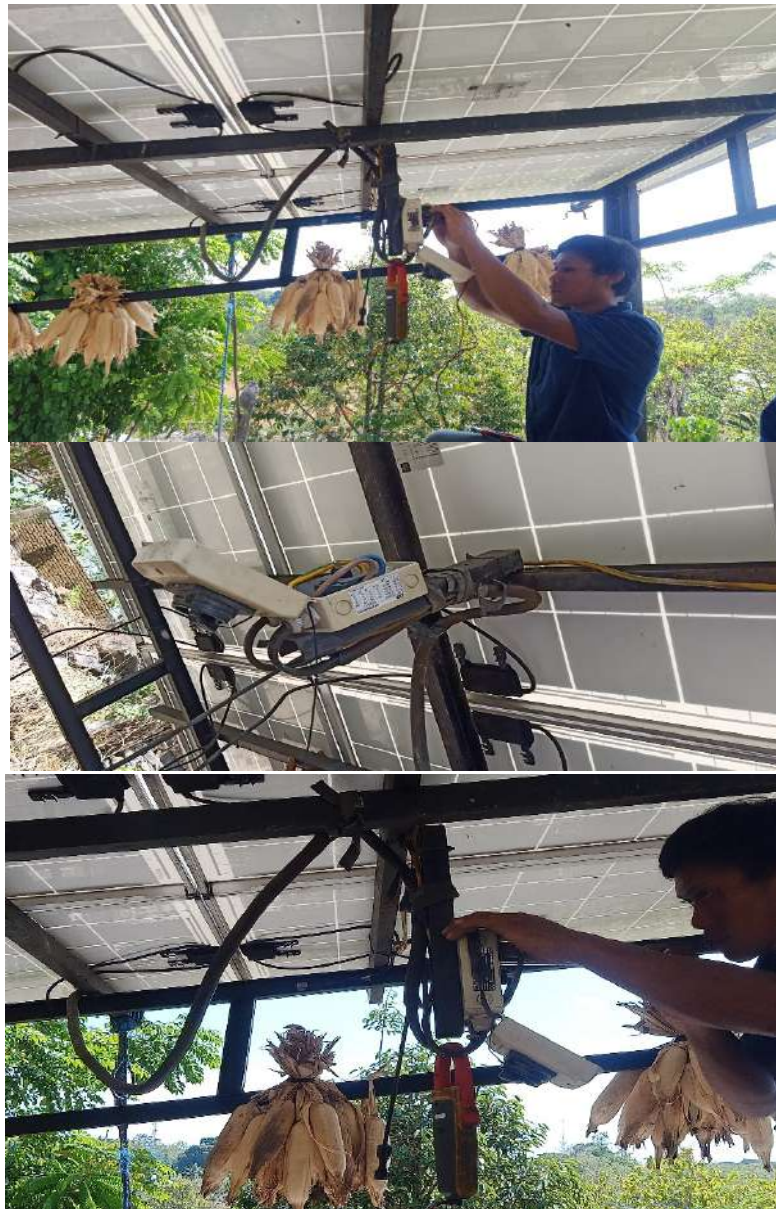
Gambar 6. Pembenahan instalasi panel surya untuk optimasi energi alternatif
