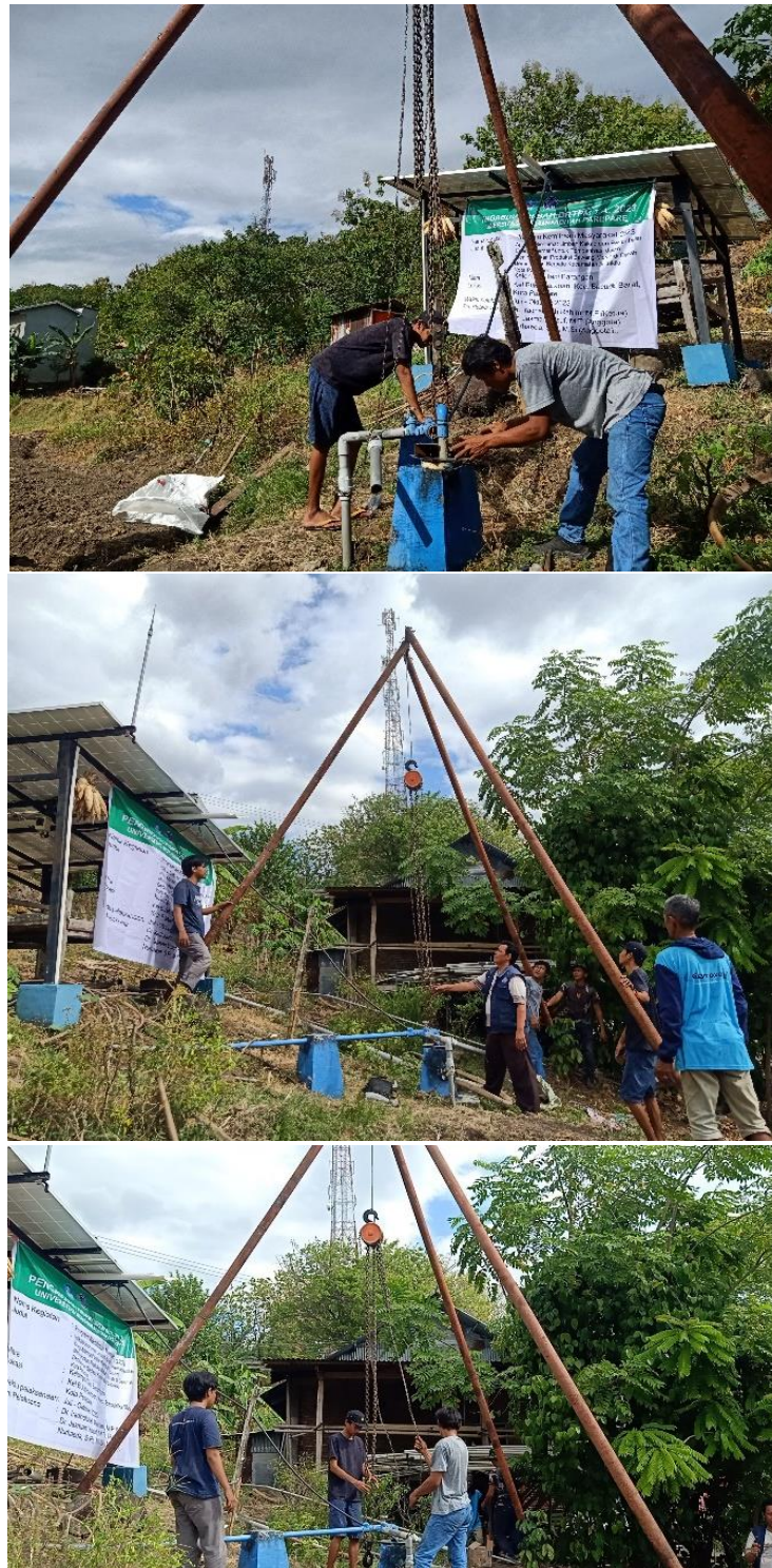
Gambar 7. Pembenahan sumber dan pompa air untuk mendapatkan debit air yang cukup sesuai target kegiatan.
