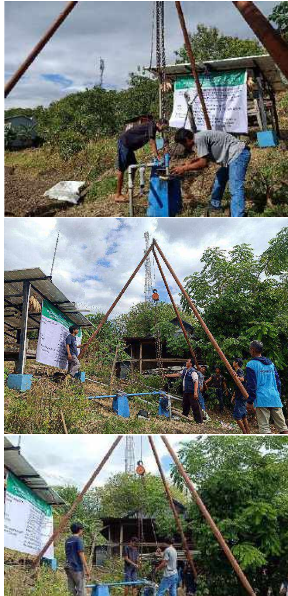
Gambar 7. Pembenahan sumber dan pompa air untuk mendapatkan debit air yang cukup sesuai target kegiatan.
