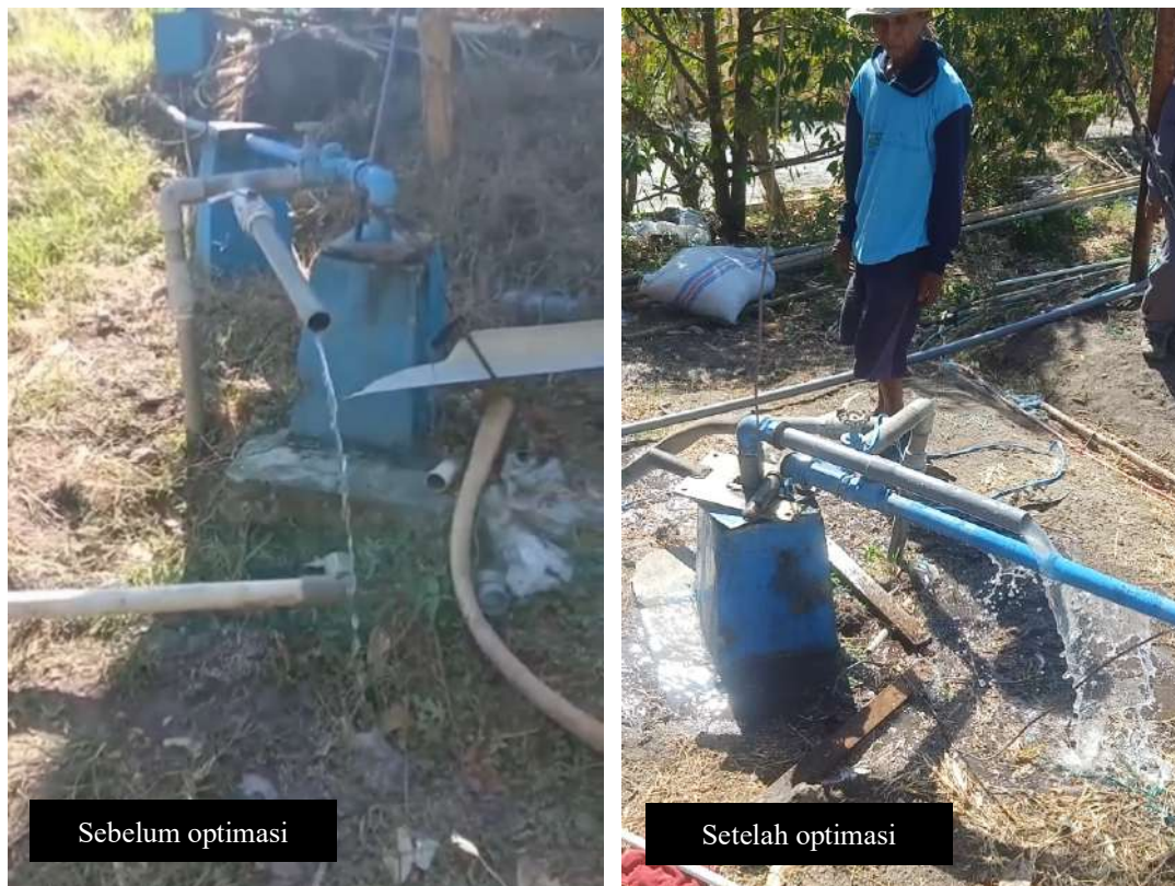
Gambar 8. Debit air sebelum dan setelah dilakukan optimasi pompanisasi air dengan energi alternatif tenaga surya
