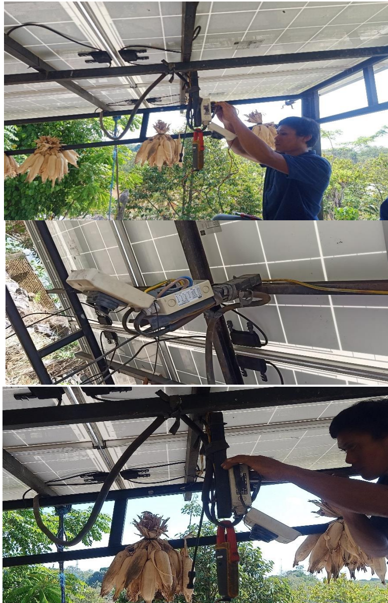
Gambar 6. Pembenahan instalasi panel surya untuk optimasi energi alternatif Kegiatan pembenahan dan instalasi telah rampung 100%. Instalasi telah dibenahi dan dirapikan, sehingga energi surya yang ditangkap bisa maksimal.
